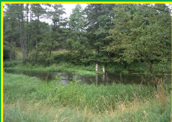
Widok na Wdę koło Krępki i słupy – pozostałości po drewnianym moście na „drodze połomskiej”
